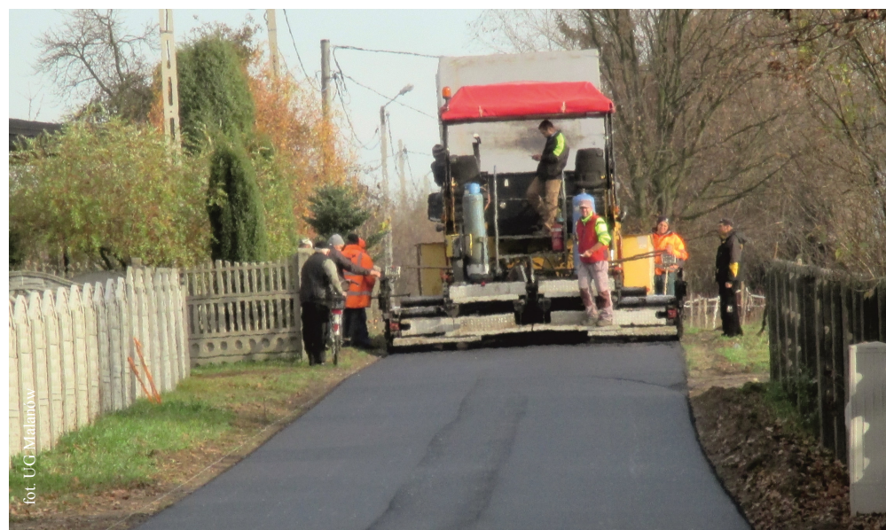
Wyremontowana droga w Dziadowicach Folwarku
