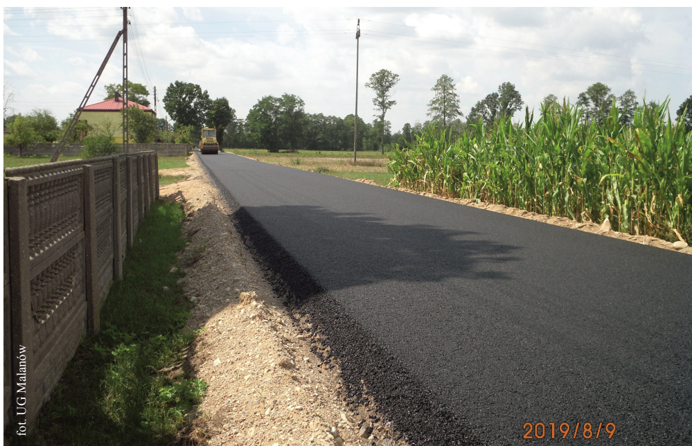
Budowa drogi w Feliksowie - etap II
