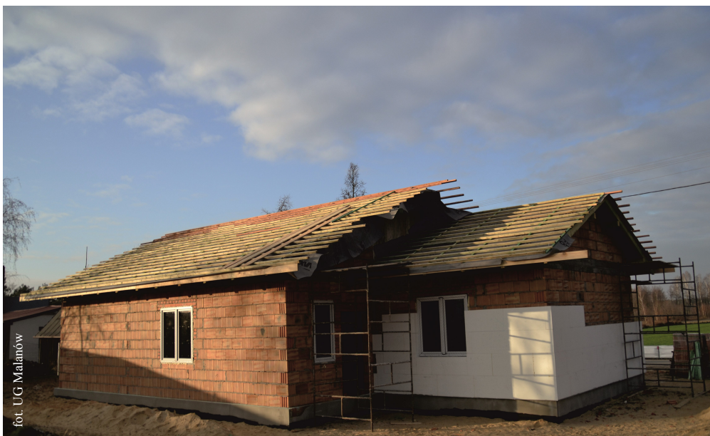
Budowa świetlicy w Celestynach
