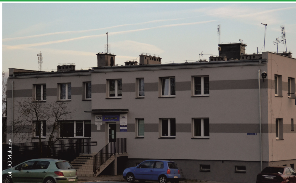
Odnowiona elewacja budynku Ośrodka Zdrowia
